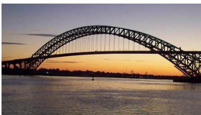
Bayonne Bridge, NY
